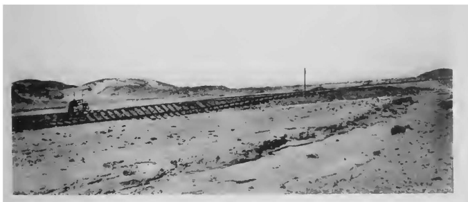
2 - Digue du chemin de fer emportée par l'attaque oblique du torrent de l'ouady Liblab
