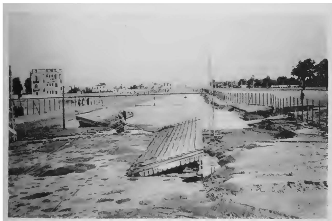
2 - La tranchée du Métro. Station Pont de Koubbeh Janvier 1919
